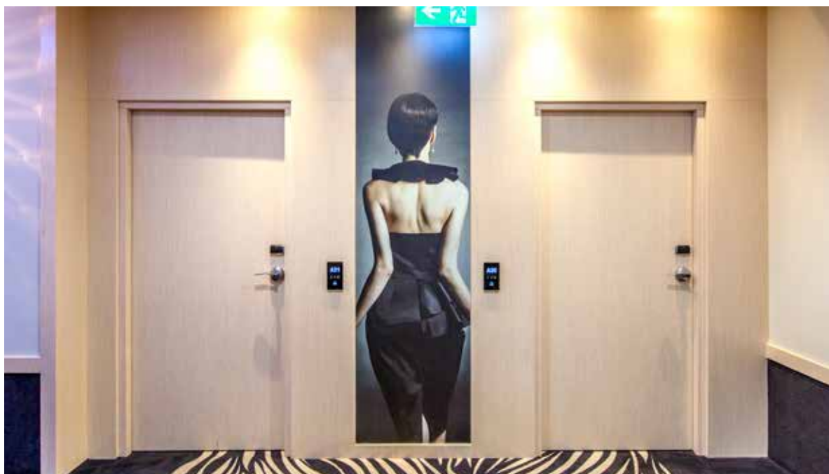
FR EI30 SR 37dB fire door, fixed wooden door frame
