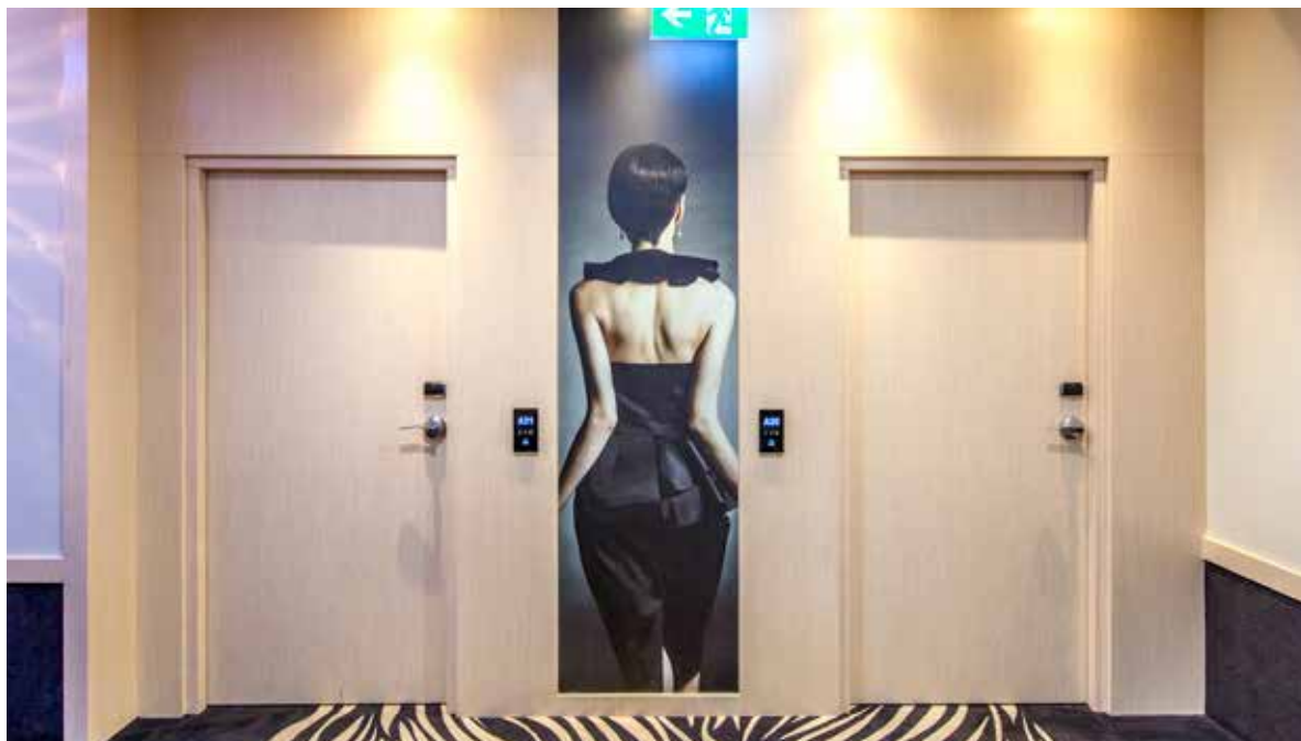
FR EI30 SR 42 fire door, fixed wooden door frame
